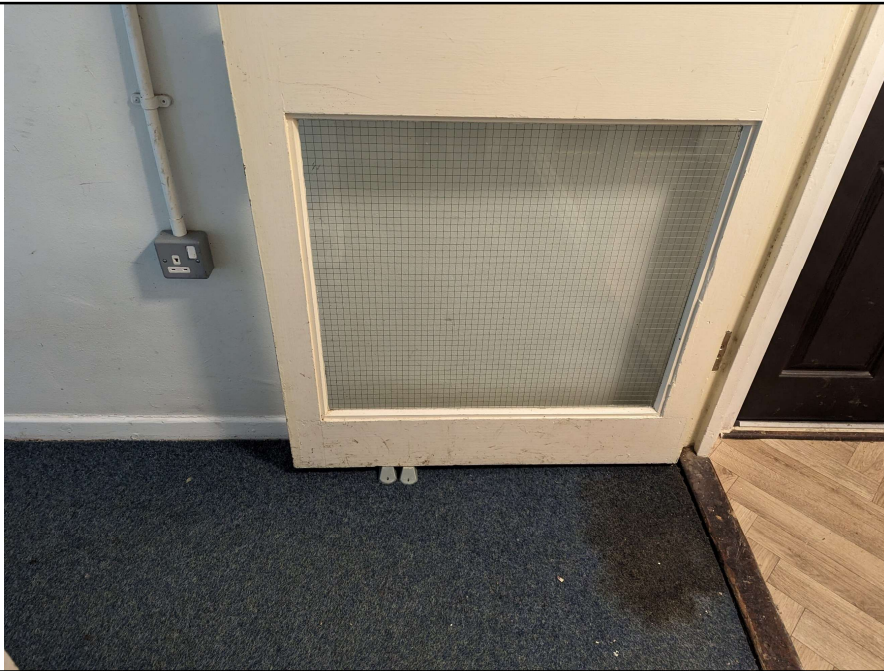
Wedges under Fire Door nr 29C/D
